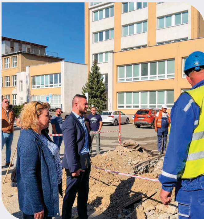
Kontrolný deň na stavbe rekonštrukcie parkoviska.
